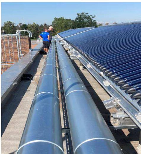
Abb. 15: Solarwärmekollektoren WQW, auf der Stadthalle
