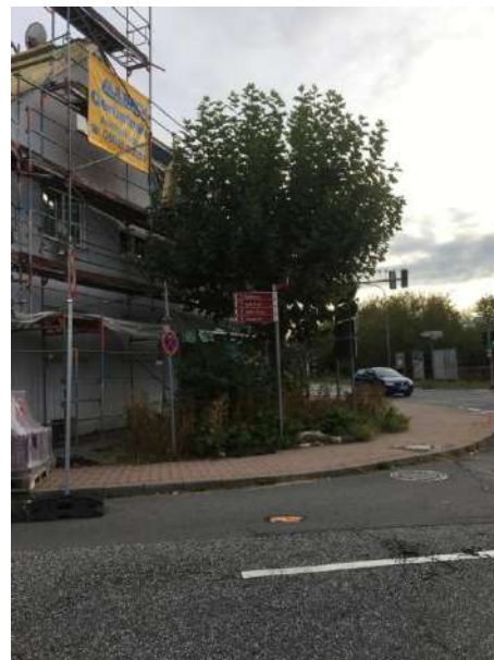
Bild links: Beschilderung am Bahnhof Mörfelden Richtung Stadtmitte / Langener Straße: Frequenzabbruch durch leerstehende Ladenlokale / Bild rechts: Beschilderung Richtung Rathaus Ecke Langgasse / Gerauer Straße
