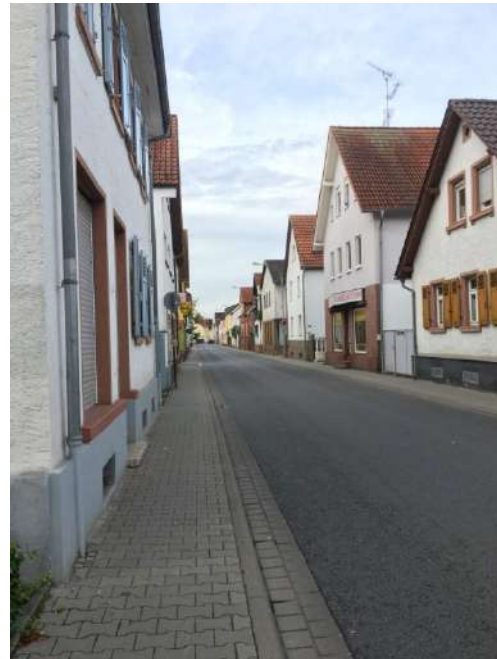
Bild links: auslaufender Besatz und geringe städtebauliche Qualität in der Langener Straße (Blick von Westen) / Bild rechts: auslaufender Besatz in der Westendstraße (Blick von Osten)
