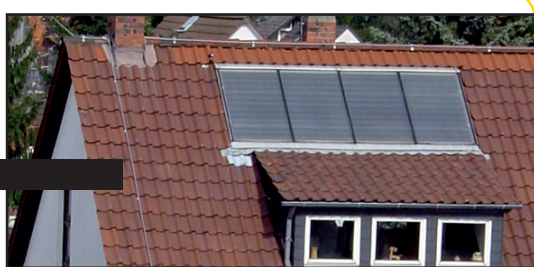
06 B13 Sonnenwärmanlage Platanenallee 27 Ansprechpartner → Ulrich Raiss Fon 0 61 05 94 36 34
